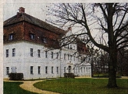
Von außen gab es im vorigen Jahr einen neuen Anstrich, die Fenster sind neu.
